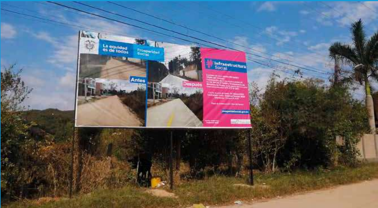
Ilustración 1 Construcción vías urbanas en el municipio de Ocaña-Norte de Santander. Convenio 372-2017. Fotografía Alexander Téllez (Banco de Imágenes de Prosperidad Social)
