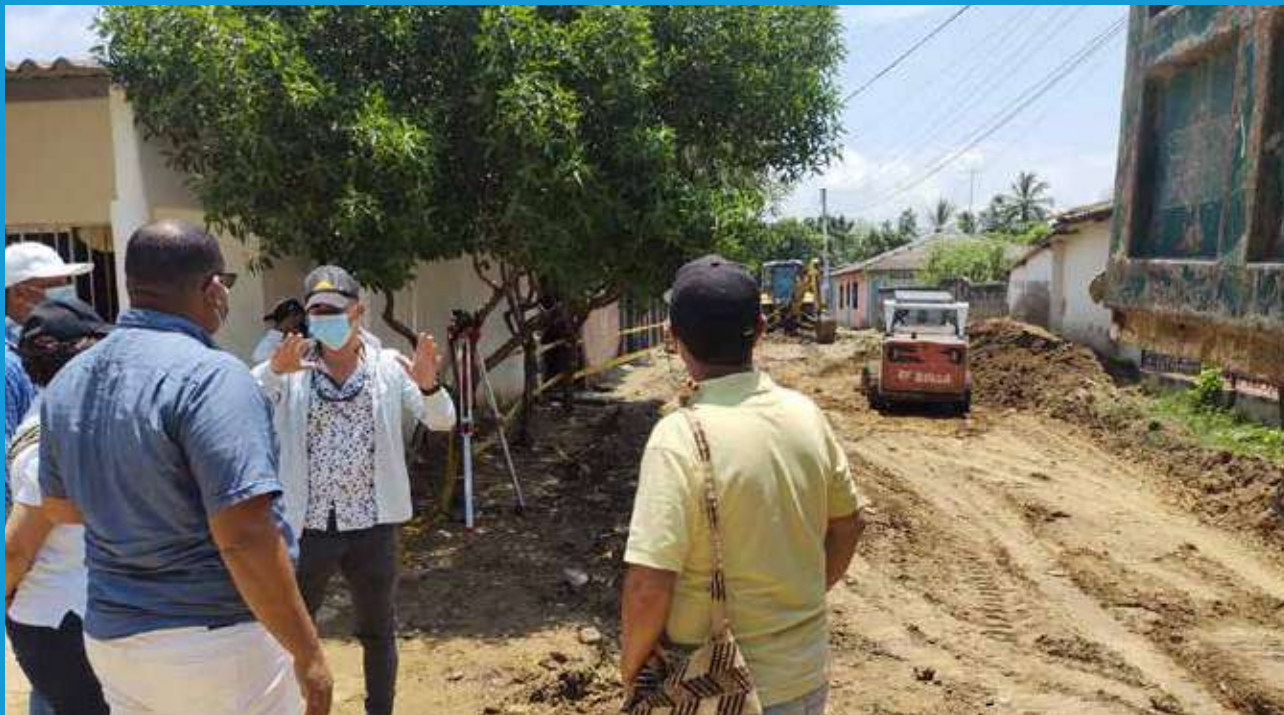
Ilustración 2 Construcción de pavimento rígido, en las vías del municipio de Pedraza, departamento del Magdalena. Convenio 461-2021. Fotografía: Marbel Ariza (Banco de imágenes de Prosperidad Social).
